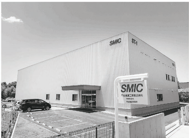
はんだ材料のラボを開設した中部事業所
