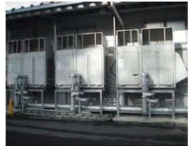
▲生産に応じ、チラー設備の台数制御運転で省エネを実施(千住電子工業)
